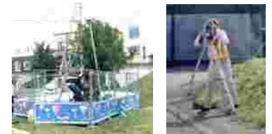
ボーリング調査
